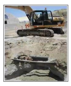
• No se permitirá, por ningún motivo, la presencia de personal en una excavación durante la realización de operaciones con equipo mecánico, durante la operación de relleno de la zanja ni bajo la vertical del equipo o tubería a instalarse.
